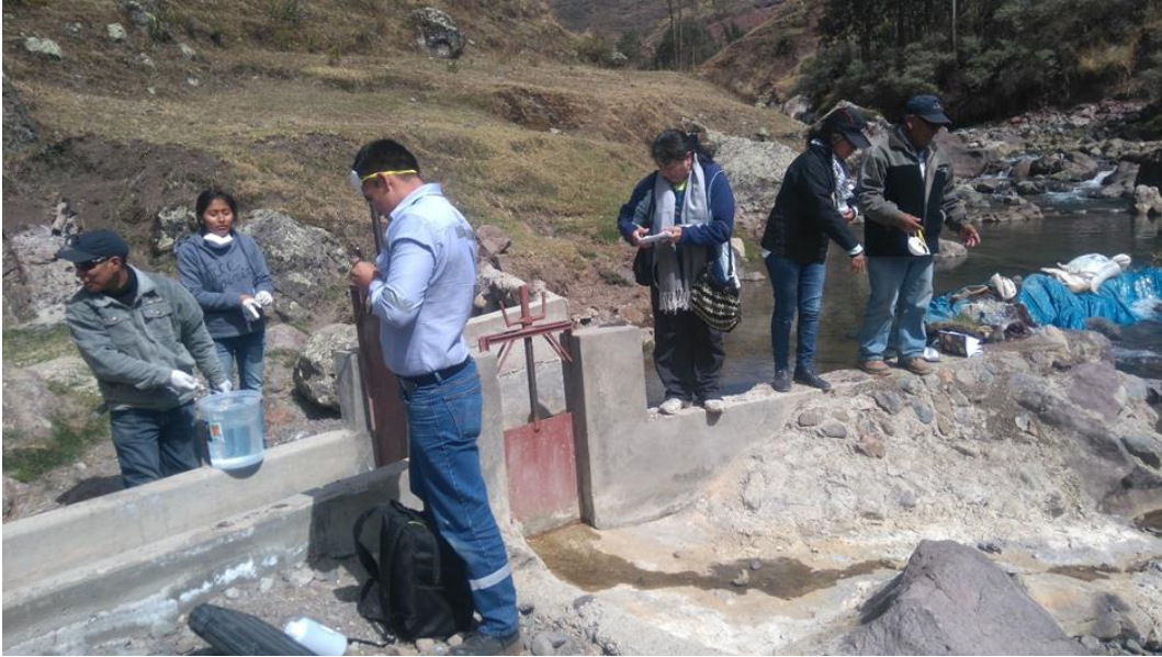
Subcuenca Quebrada Parac-Río Aruri-Canal Riego Parac Chucllapampa.
